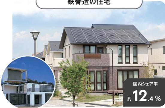
鉄骨造の住宅は、主要構造部が重量鉄骨と軽量鉄骨の2種類存在する。一般的に自由設計で設計される場合は重量鉄骨が多く、軽量鉄骨はプレハブ住宅メーカーが構造認定を取得して商品化するケースが多い。内装は、新建材でも自然素材でも自由にデザインすることが出来る。プレハブ住宅メーカーの多くはこの構造の商品構成を持ち、中にはユニット工法を持ち、工期を大幅に短縮している会社もある。
