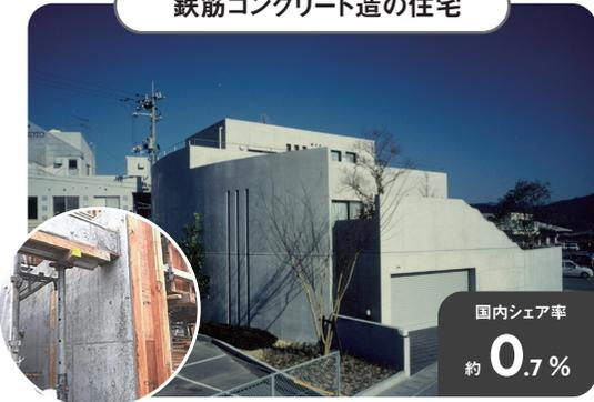
鉄筋コンクリート造住宅は、柱や梁、壁、床などの主要構造部分が鉄筋コンクリートで出来ている。コストがかかることから、構造的特徴が活かせる斬新なデザインや構造的強度を求める人向けの住宅とも言える。少数だが、コンクリート系住宅を供給するプレハブメーカーも存在する。内装は新建材でも自然素材でも自由にデザインすることが可能だが、比較的モダンなデザインが似合う。
