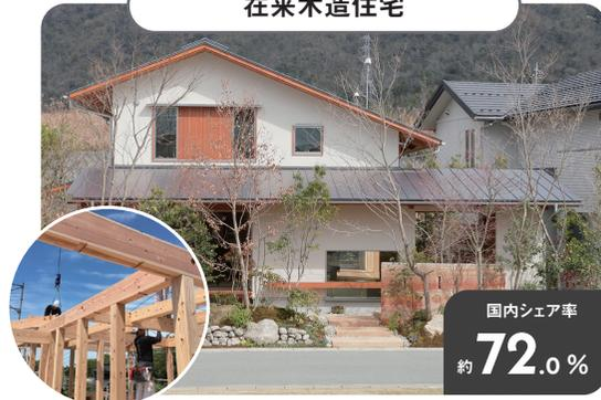
柱や梁桁などの主要構造部が木材の住宅。構造材の種類として、集成材など木材片を貼り合わせた高強度の木材を金具で接合するものや、国産材などをその素材のまま従来の接合加工を活かして組み上げるものもある。戸建て住宅の中では木造在来工法の住宅が最も多い。内装は、新建材でも自然素材でも自由に施工することが出来る。ローコストから高級住宅まですべての価格帯において新建材は使用されるが、自然素材は比較的高級な価格帯で使用されることが多い。
