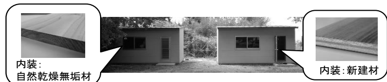
図1 実験棟概要（左：無垢材棟、右：新建材棟）
